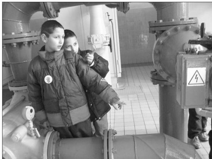
Đeti z dětských domovů si prohlédli úpravnu vody ve Vítkově.
