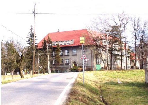
Škola před opravou
