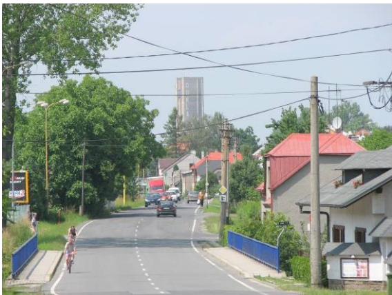
Pohled na železobetonovou věž z Fryštátské ulice
