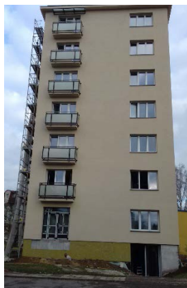
Dům na ulici J. Hory po komplexní rekonstrukci. Foto: z archivu MRA.
