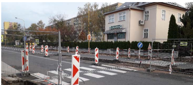
Komplexní oprava přechodu pro chodce na ulici Těšínské u autobusového nádraží.
