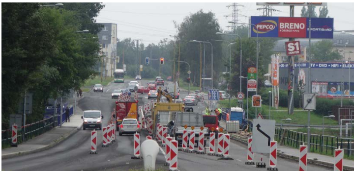
Oprava železničního mostu na Dělnické ulici se přesunula na opačnou stranu (z pohledu od Nemocnice s poliklinikou Havířov). Středa 11. července 2018.
