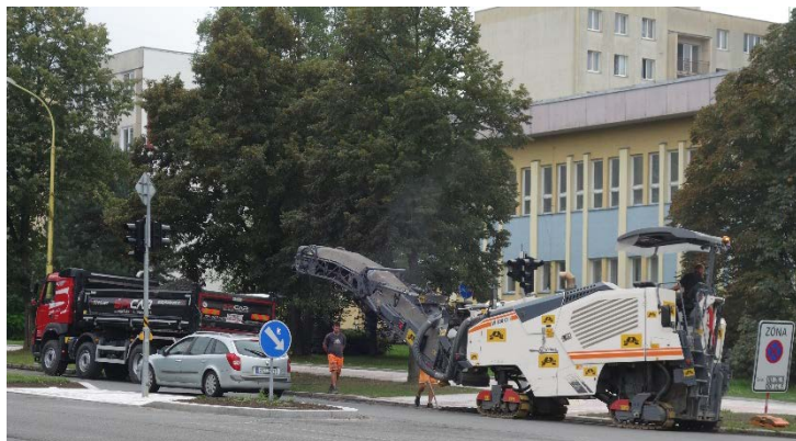
Začala rekonstrukce kilometrového úseku Dlouhé třídy, na křižovatce s ulicí 17. listopadu začala pracovat těžká technika. Čtvrtek 30. srpna 2018.
