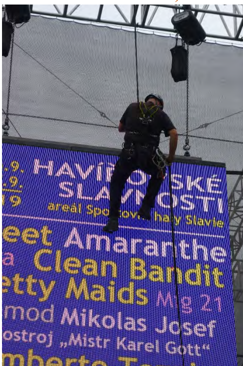
Havířovské slavnosti 2019, sobota 7. září 2019, oprava nad jevištěm.
