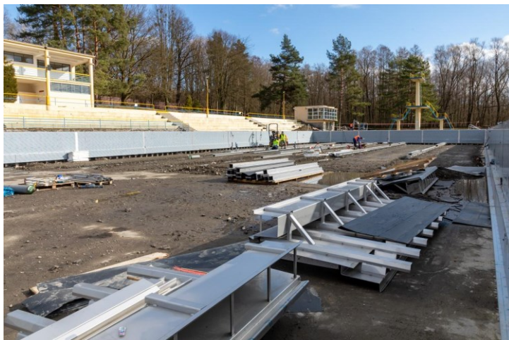
Rekonstrukce 50m bazénu na koupališti Jindřich. Foto: archiv MmH.
