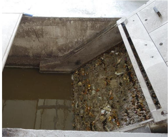
Odpad zachycený v budově hrubého předčištění.
