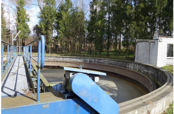
První záchyt odpadu z vody v čističce odpadních vod.
