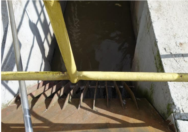
První záchyt odpadu z vody v čističce odpadních vod
