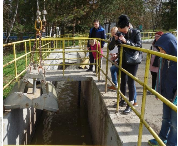
První záchyt odpadu z vody v čističce odpadních vod.
