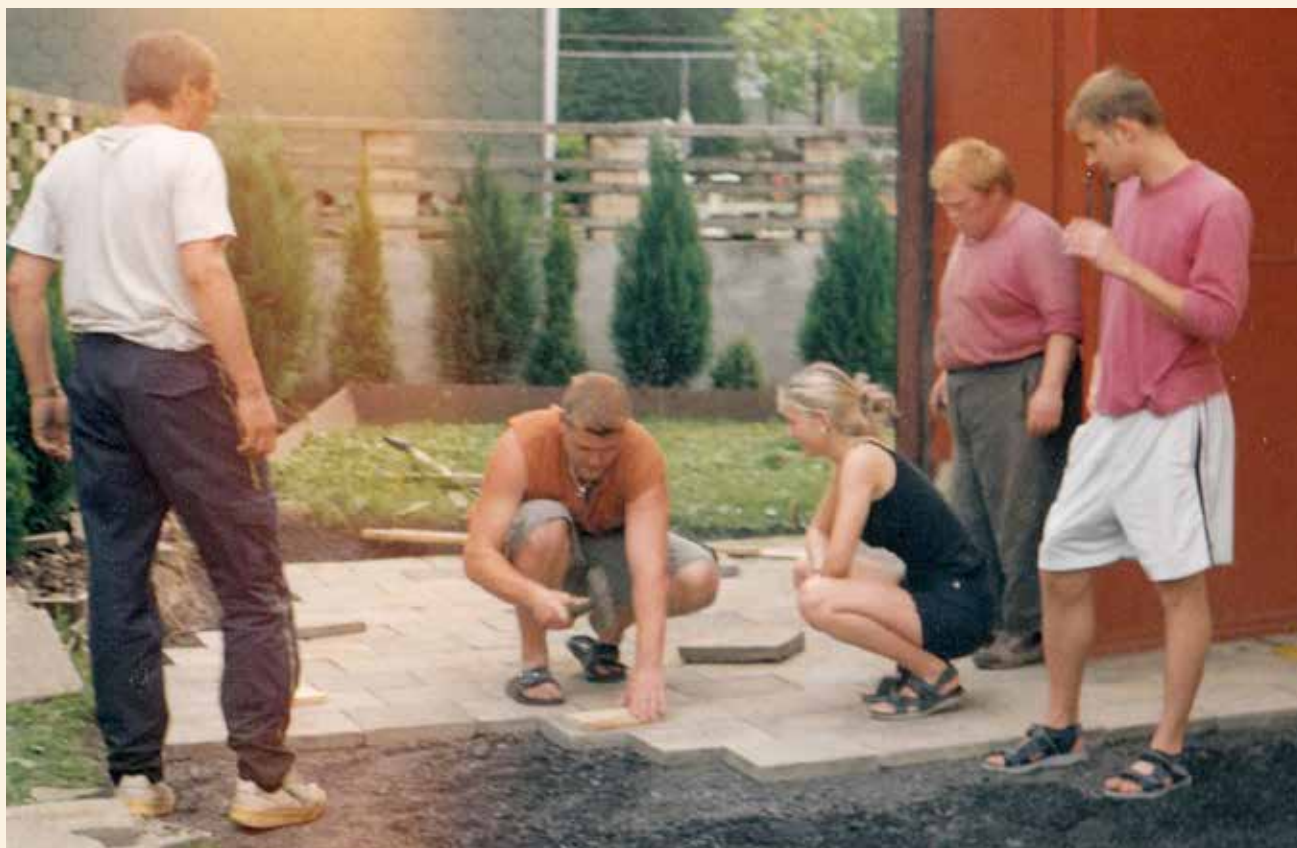
Pokládání dlažby před požární zbrojnicí.
