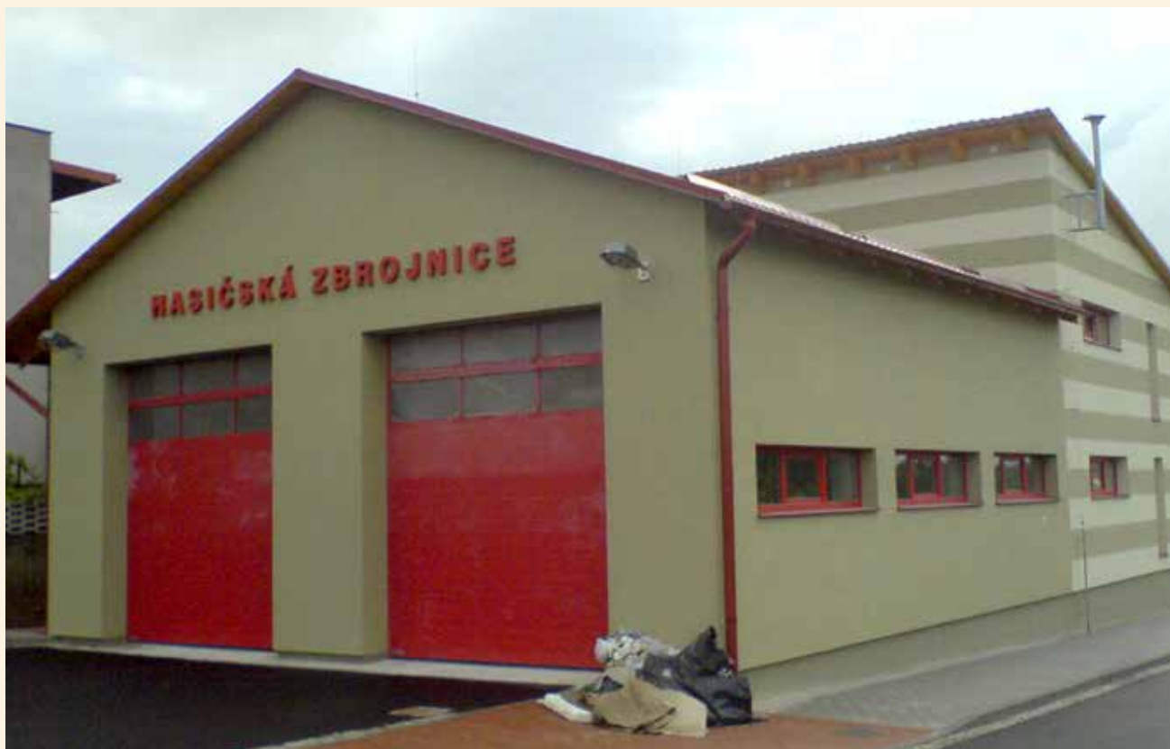
Hasičská zbrojnice těsně před dokončením v roce 2008.
