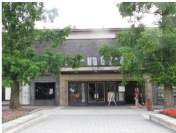
Kino Centrum před rekonstrukcí
