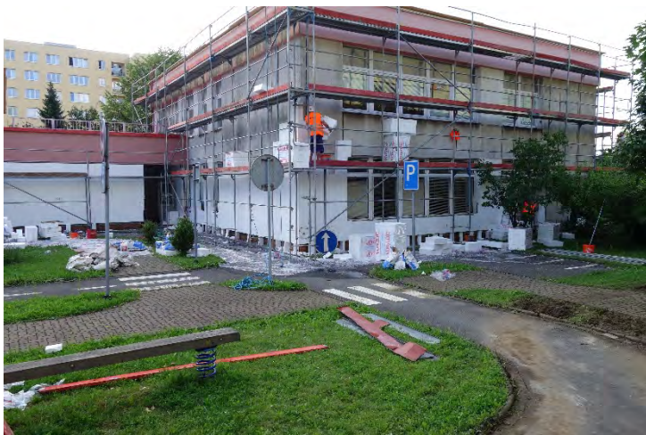
Celková revitalizace objektu MŠ Mláďí v Havířově- Šumbarku – výměna oken, zateplení fasády a střech, oprava teras – středa 20. července 2016
