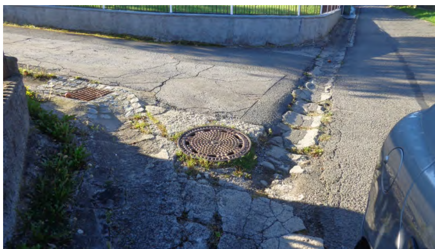
Ulice Javorová před opravou, foto z archivu Magistrátu města Havířova
