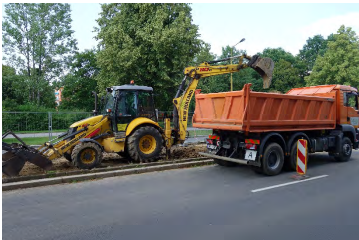
Oprava horkovodu na ulici Dlouhé – výměna potrubí – začaly výkopové práce, pátek 1. července 2016.
