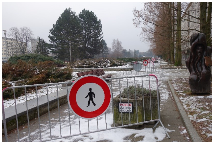
stromů rozvlnil chodník. Foceno 8. března 2022.
